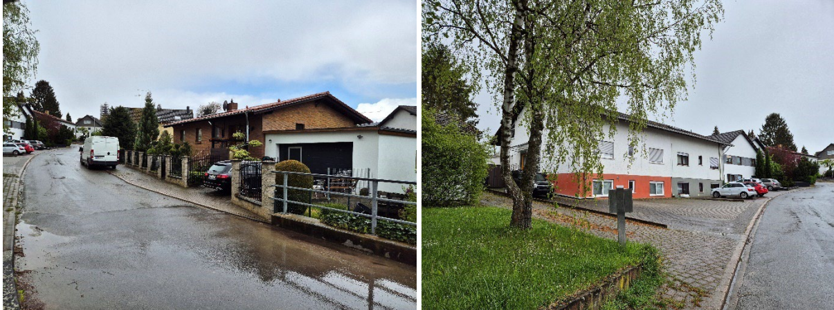
Abbildung 13: Angrenzende Bebauung im Siedlungsbereich der Gemeinde Appenheim Quelle: Planergruppe ROB GmbH (Stand 25.04.2024)
