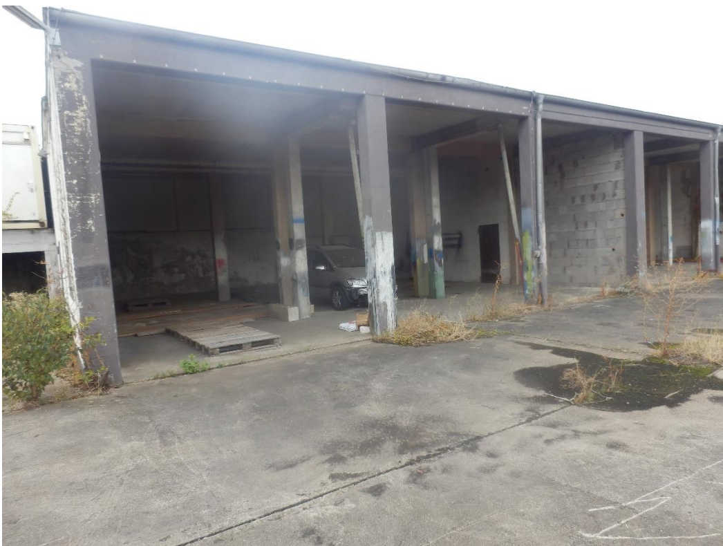
Bild 08: Der Omnibus-Carport mit den Rauchschnalbenneatern im Westen des Betriebsgeländes
