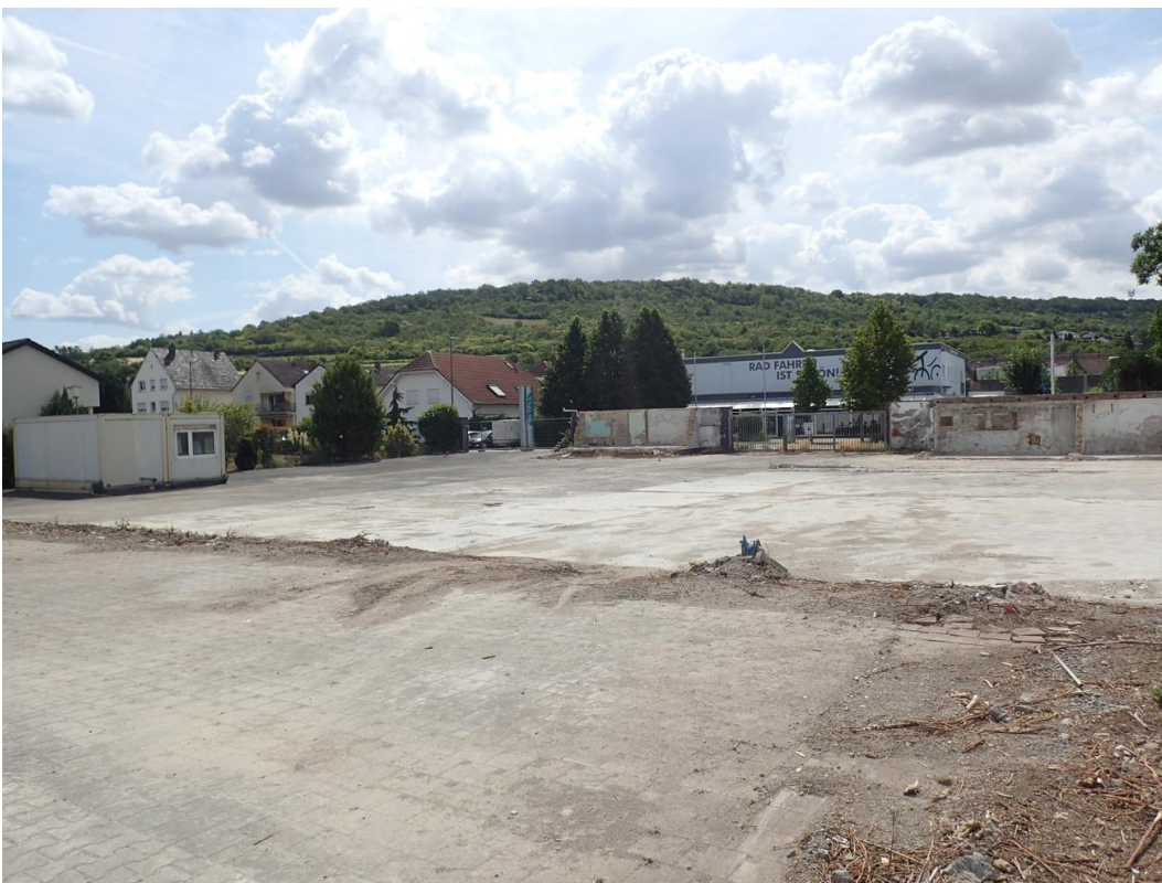
Bild 04: Das Gelände nach dem Abriss der Gebäude am 27.06.2023
