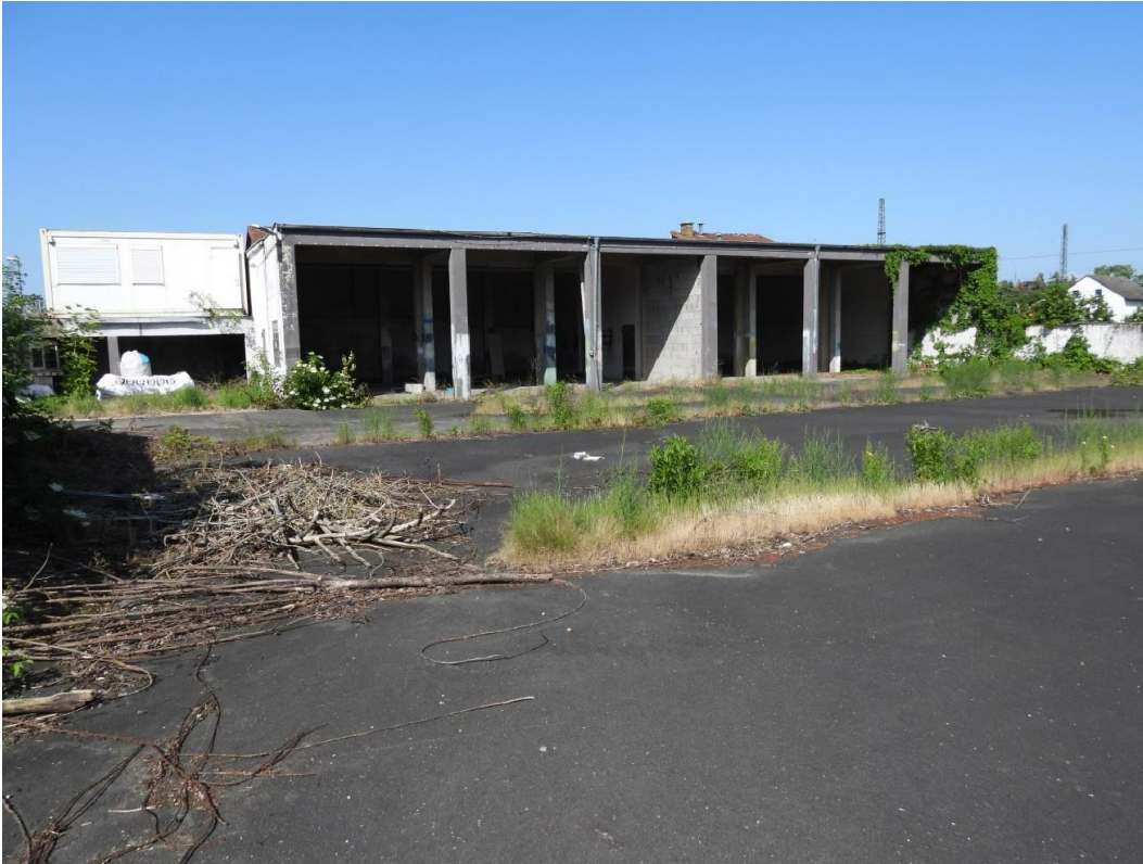
Bild 01: Abzureißende Halle mit Rauchschwalbennestern
